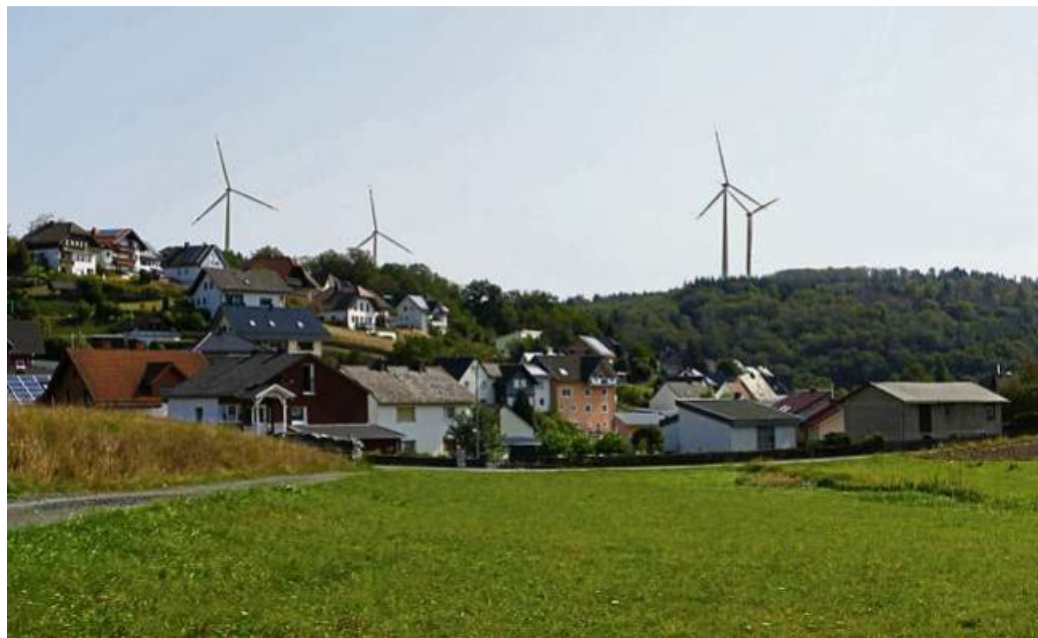
So soll der Park aus Sicht des Ortsteils Frechenhausen einmal aussehen: Rund 2,5 Millionen Euro wurden von der Energiegenossenschaft „Lahn-Dill-Bergland“ in den Windpark „Stocksol“ bei Angelburg investiert. Foto/Visualisierung: Markus Weiß/Lahn-Dill-Bergland Energiegenossenschaft
